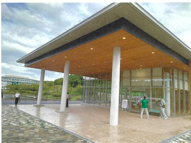
①西口休憩所入口
